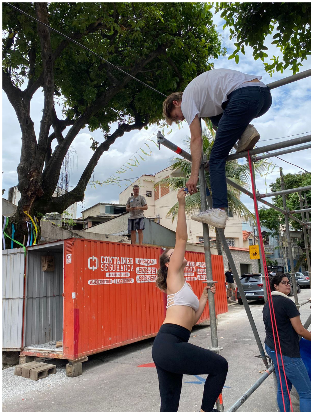
.Figura 12: Montagem dos andaimes. Fonte: Acervo próprio.
