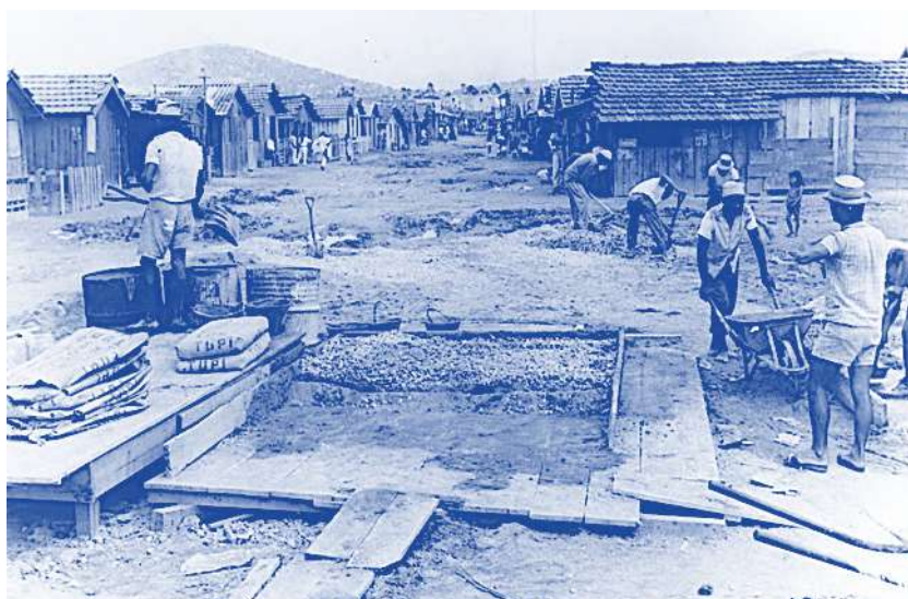
FIG. 116: PROCESSO DE AUTOCONSTRUÇÃO NO PARQUE MARÉ EM 1963. FONTE: ACERVO DO MUSEU DA MARÉ.
