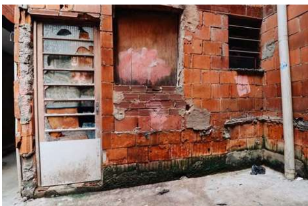
FIG. 184: CASA ORIGINAL NO CONJUNTO NOVA MARÉ. FONTE: ARTHUR VIANA (2023)
