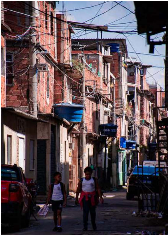
FIG. 215: GATOS NAS REDES DE ENERGIA E CAIXAS D'ÁGUA NO MEIO DA RUA NA FAVELA NOVA HOLANDA. FONTE: DOUGLAS LOPES / REDES DA MARÉ (2023)
