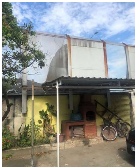
FIG. 278: ESTRUTURA DO MURO UTILIZADA PARA IMPLANTAÇÃO DE ÁREA DE LAZER COBERTA. FONTE: AUTORA (2023)
