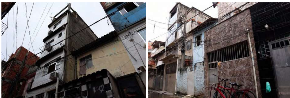
FIG. 131: FOTOS DE CASAS NO TIJOLINHO, EM NOVA HOLANDA. FONTE: ARTHUR VIANA (2023)
