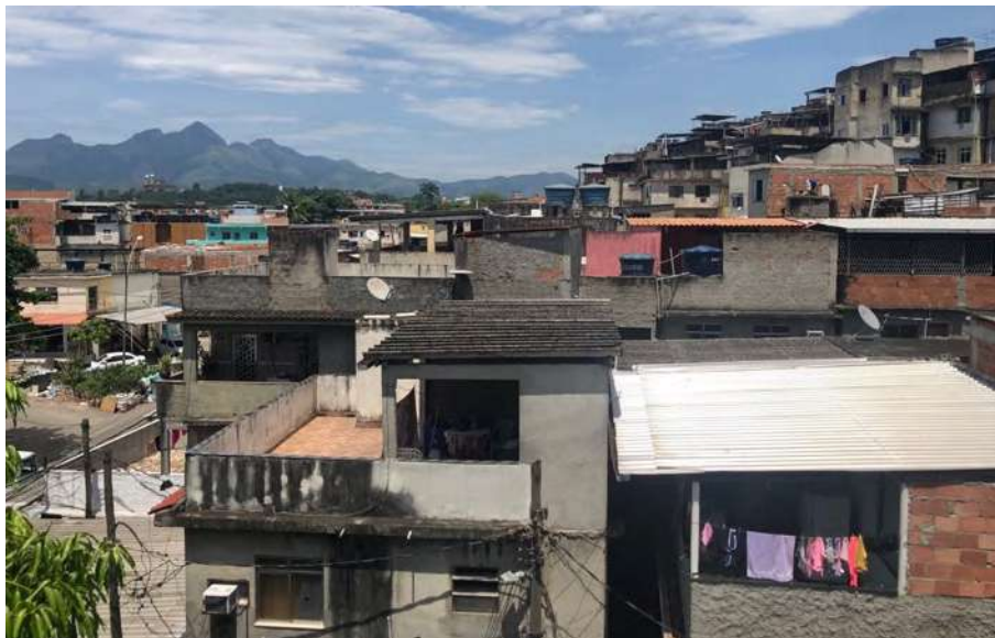
FIG. 235: VISTA DAS LAJES NO MORRO DO TIMBAU. FONTE: AUTORA (2023)
