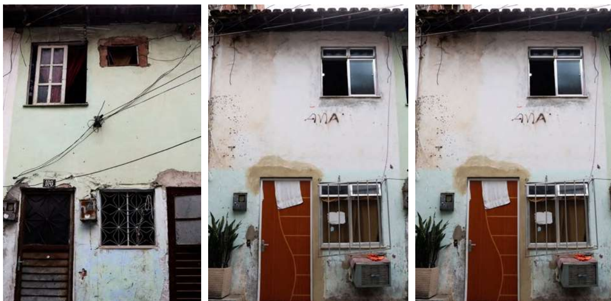
FIG. 128: FOTOS DE CASAS NO TIJOLINHO, EM NOVA HOLANDA. FONTE: ARTHUR VIANA (2023)
