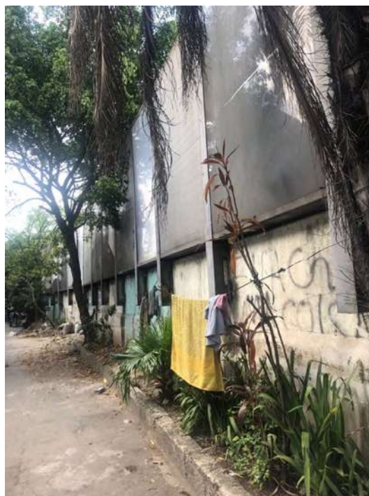
FIG. 274: ESTRUTURA DO MURO UTILIZADA PARA VARAL DE ROUPA. FONTE: AUTORA (2023)
