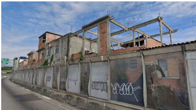
FIG. 283: CONSTRUÇÕES OCUPANDO A FAIXA LINDEIRA DA AV. BENTO RIBEIRO DANTAS. FONTE: GOOGLE STREET VIEW (2023)
