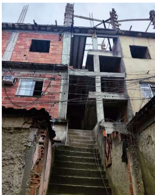
FIG. 193: ESTRUTURA DE CONCRETO ARMADO SENDO REALIZADA EM NOVA HOLANDA. FONTE: ARTHUR VIANA (2023)
