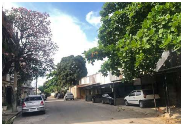
FIG. 280: GARAGENS COBERTAS AO LONGO DO MURO DA LINHA VERMELHA. FONTE: AUTORA (2023)
