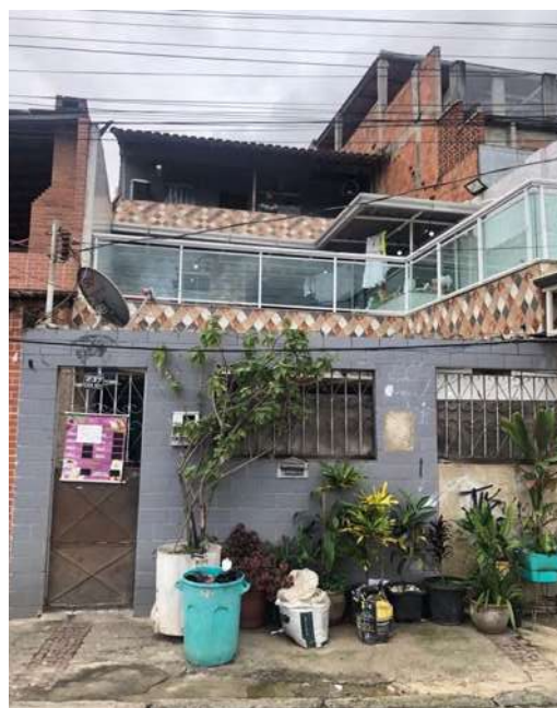
FIG. 194: CASA COM REVESTIMENTO CERÂMICO E GUARDA-CORPO DE ALUMÍNIO E VIDRO EM BENTO RIBEIRO DANTAS. FONTE: AUTORA (2023)
