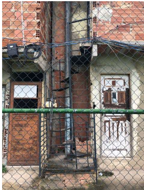
FIG. 262: ESCADA CONSTRUÍDA APROVEITANDO BRECHA DO POSTE. FONTE: AUTORA (2023)
