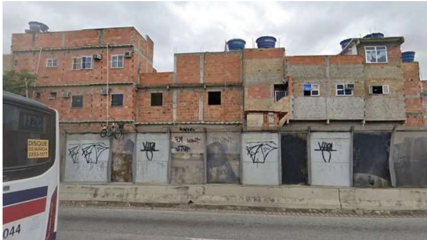
FIG. 282: CONSTRUÇÕES RECENTES OCUPANDO A FAIXA LINDEIRA DA LINHA VERMELHA. FONTE: GOOGLE STREET VIEW (2023)
