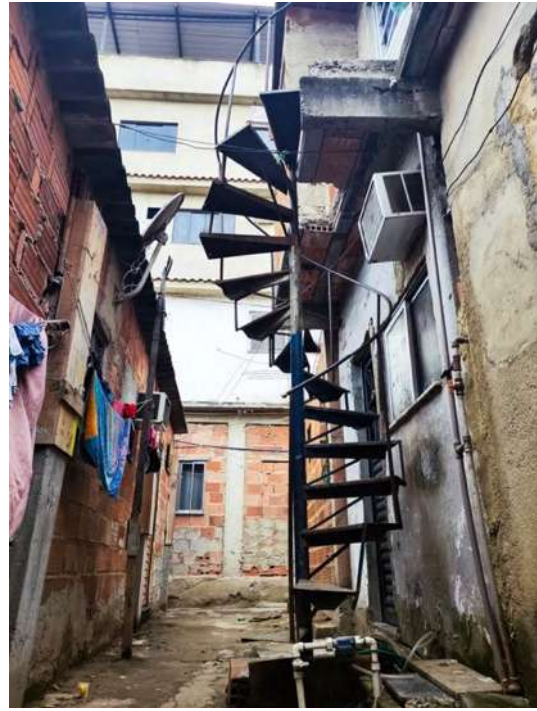
FIG. 242: ESCADA CONSTRUÍDA SOBRE RUA EM NOVA HOLANDA. FONTE: ARTHUR VIANA (2023)
