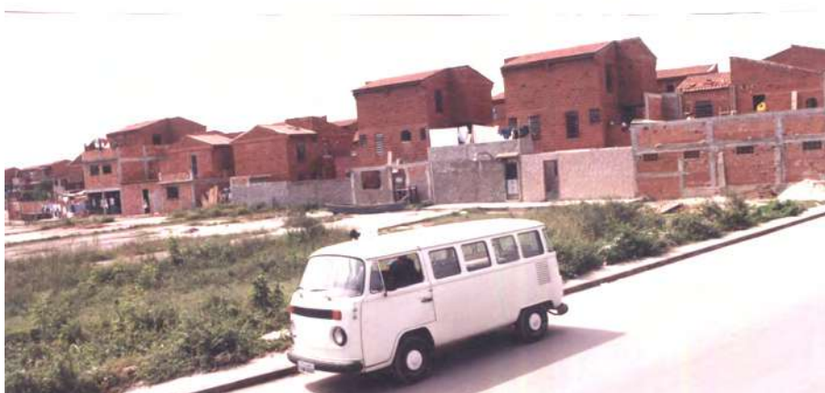
FIG. 169: CONJUNTO BENTO RIBEIRO DANTAS NO ANO 2000, QUANDO JÁ SE OBSERVA UMA SÉRIE DE AMPLIAÇÕES SENDO REALIZADAS. FONTE: ACERVO DO MUSEU DA MARÉ.
