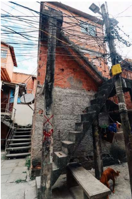
FIG. 243: ESCADA EXTERNA PARA ACESSO AO PAVIMENTO SUPERIOR NO CONJUNTO NOVA MARÉ. FONTE: ARTHUR VIANA (2023)
