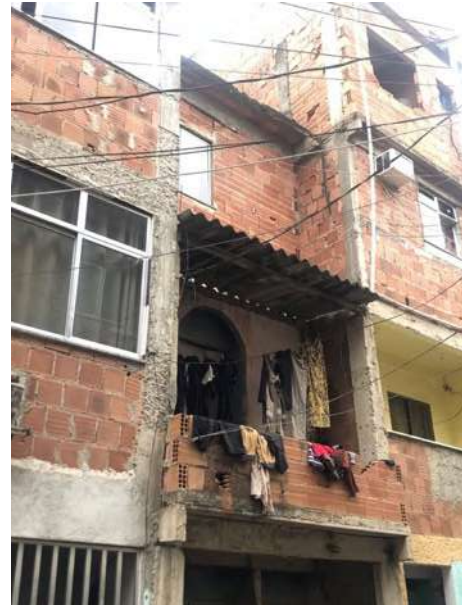
FIG. 135: REMANESCENTES DA ESQUADRIA ORIGINAL EM FORMATO DE ARCO. FONTE: AUTORA (2023)
