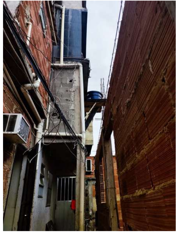
FIG. 218: GATOS E CAIXA D'ÁGUA SOBRE A RUA, NOVA HOLANDA, MARÉ. FONTE: ARTHUR VIANA (2023)
