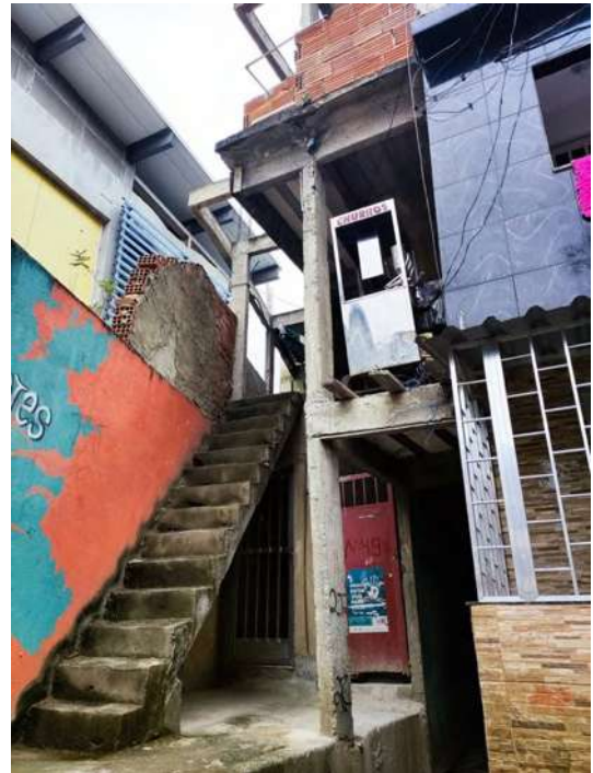
FIG. 334: AMPLIAÇÕES DE CASA EM NOVA HOLANDA. FONTE: AUTORA (2023)
