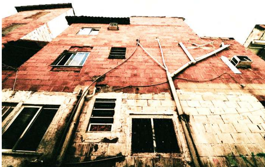
FIG. 212: FACHADA DE CASA EM NOVA MARÉ. FONTE: ARTHUR VIANA (2023)
