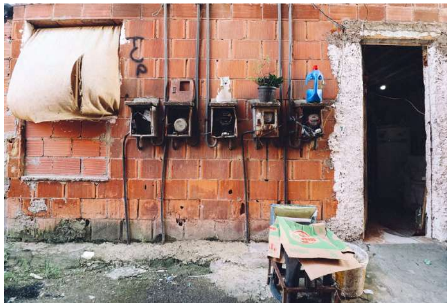
FIG. 1: FACHADA DE CASA NO CONJUNTO NOVA MARÉ. FONTE: ARTHUR VIANA (2023)
