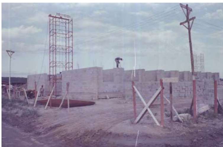
FIG. 149: CONJUNTO PINHEIRO EM CONSTRUÇÃO. FONTE: ACERVO DO MUSEU DA MARÉ.
