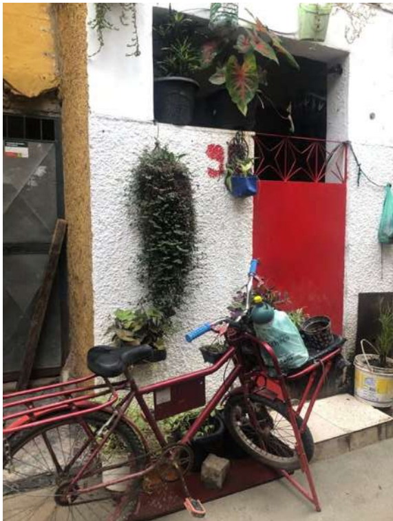
FIG. 321: FACHADA DE CASA EM NOVA HOLANDA. FONTE: AUTORA (2023)
