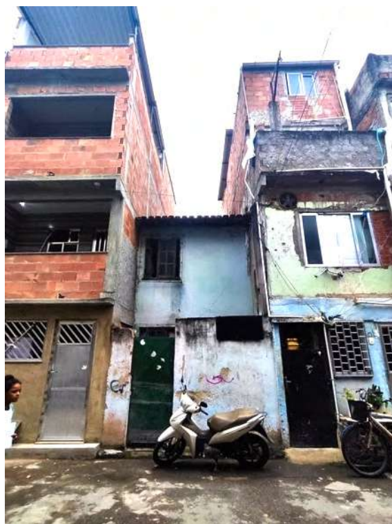
FIG. 132: FOTOS DE CASAS NO TIJOLINHO, EM NOVA HOLANDA. FONTE: ARTHUR VIANA (2023)
