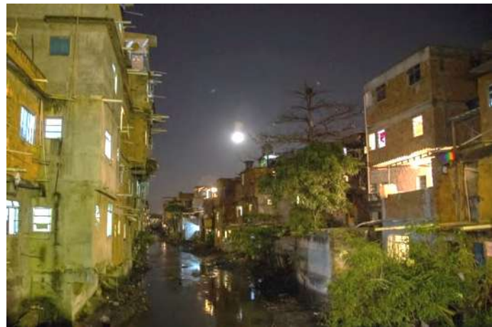
FIG. 180: EDIFICAÇÕES CONSTRUÍDAS SOBRE ATERROS NA MARGEM DE UM VALÃO. FONTE: ROSILENE MILIOTTI / IMAGENS DO POVO
