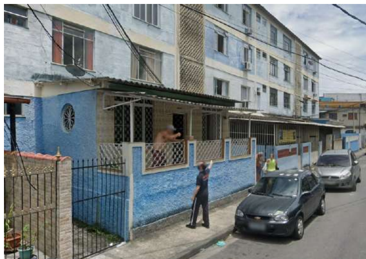
FIG. 54: PUXADINHOS REALIZADOS PELOS MORADORES NO CONJUNTÃO DE BANGU. FONTE: GOOGLE STREET VIEW (2023)
