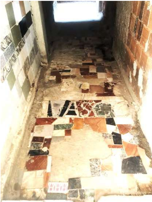
FIG. 333: PISO DE CACOS CERÂMICOS EM BECO DE NOVA HOLANDA. FONTE: AUTORA (2023)
