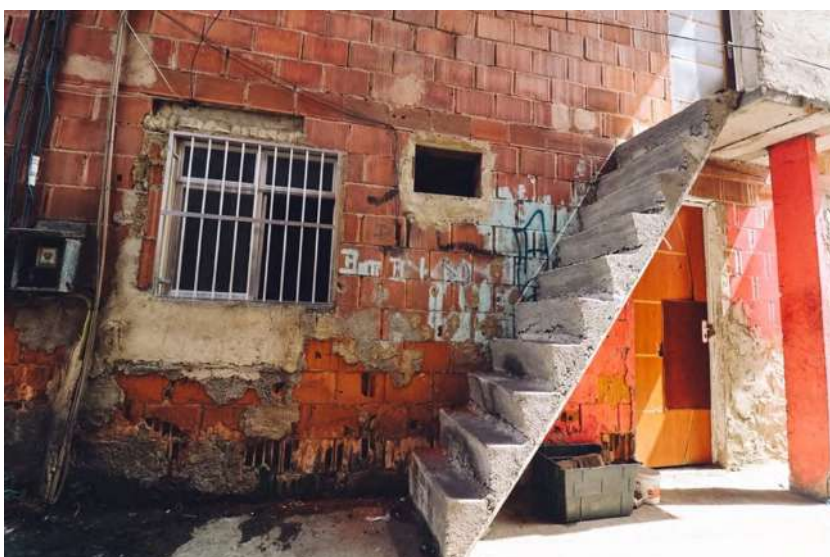
FIG. 245: ESCADAS ASTUCIOSAS ENCONTRADAS NO CONJUNTO NOVA MARÉ. FONTE: ARTHUR VIANA (2023)
