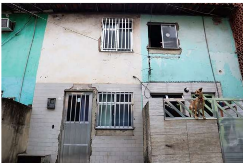
FIG. 129: FOTOS DE CASAS NO TIJOLINHO, EM NOVA HOLANDA. FONTE: ARTHUR VIANA (2023)
