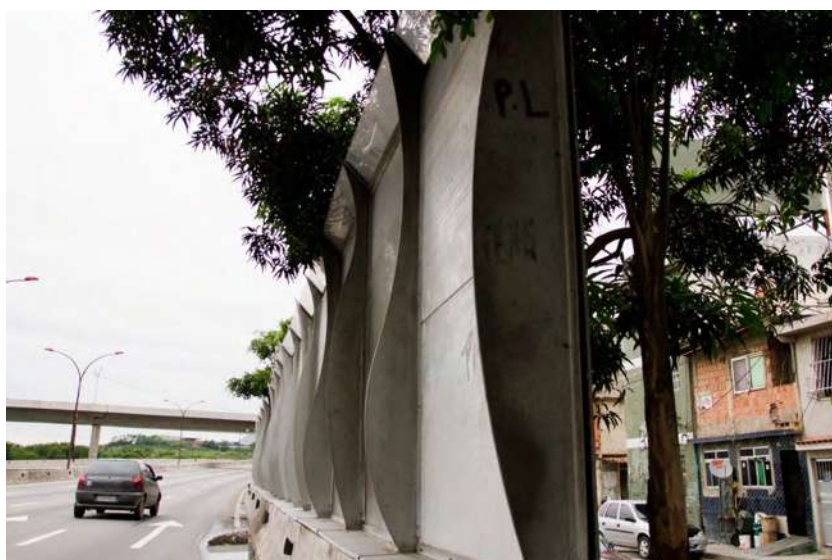
FIG. 270: BARREIRA ACÚSTICA SEPARANDO A LINHA VERMELHA DA MARÉ. FONTE: ROSILENE MILIOTTI / IMAGENS DO POVO
