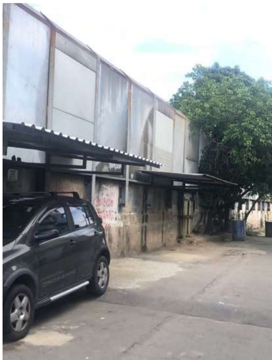
FIG. 275: ESTRUTURA DO MURO UTILIZADA PARA VAGAS DE GARAGEM COBERTAS. FONTE: AUTORA (2023)
