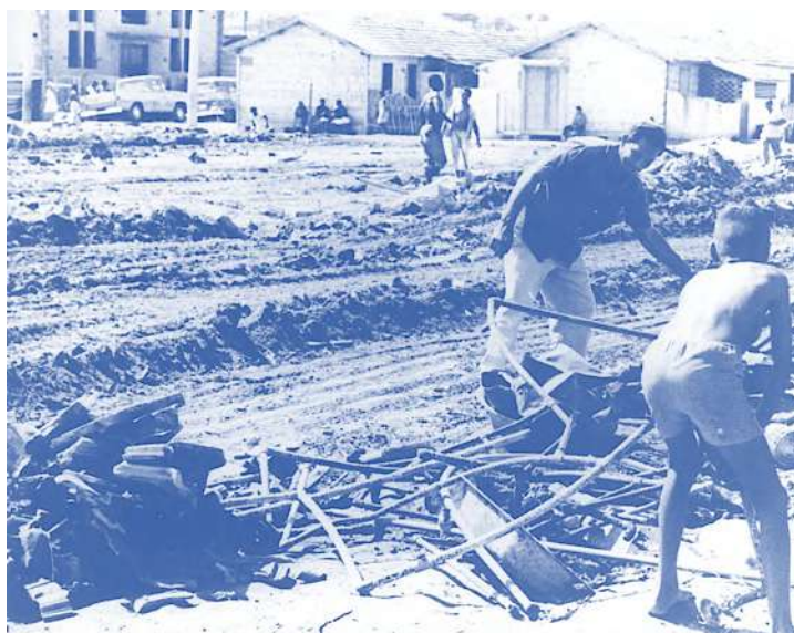
FIG. 119: MORADORES TRABALHANDO NO RECOLHIMENTO DE ENTULHOS E NA ABERTURA DE VIA EM NOVA HOLANDA (1967).
