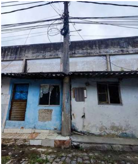
FIG. 286: CASAS QUE SE APROVEITAM DO POSTE DE ILUMINAÇÃO COMO PILAR. FONTE: ARTHUR VIANA (2023)
