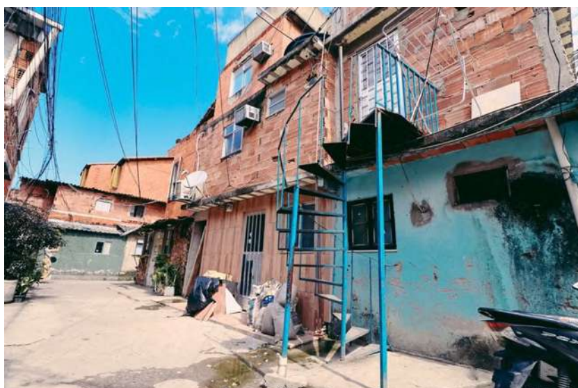
FIG. 240: ESCADAS ASTUCIOSAS ENCONTRADAS NO CONJUNTO NOVA MARÉ. FONTE: ARTHUR VIANA (2023)
