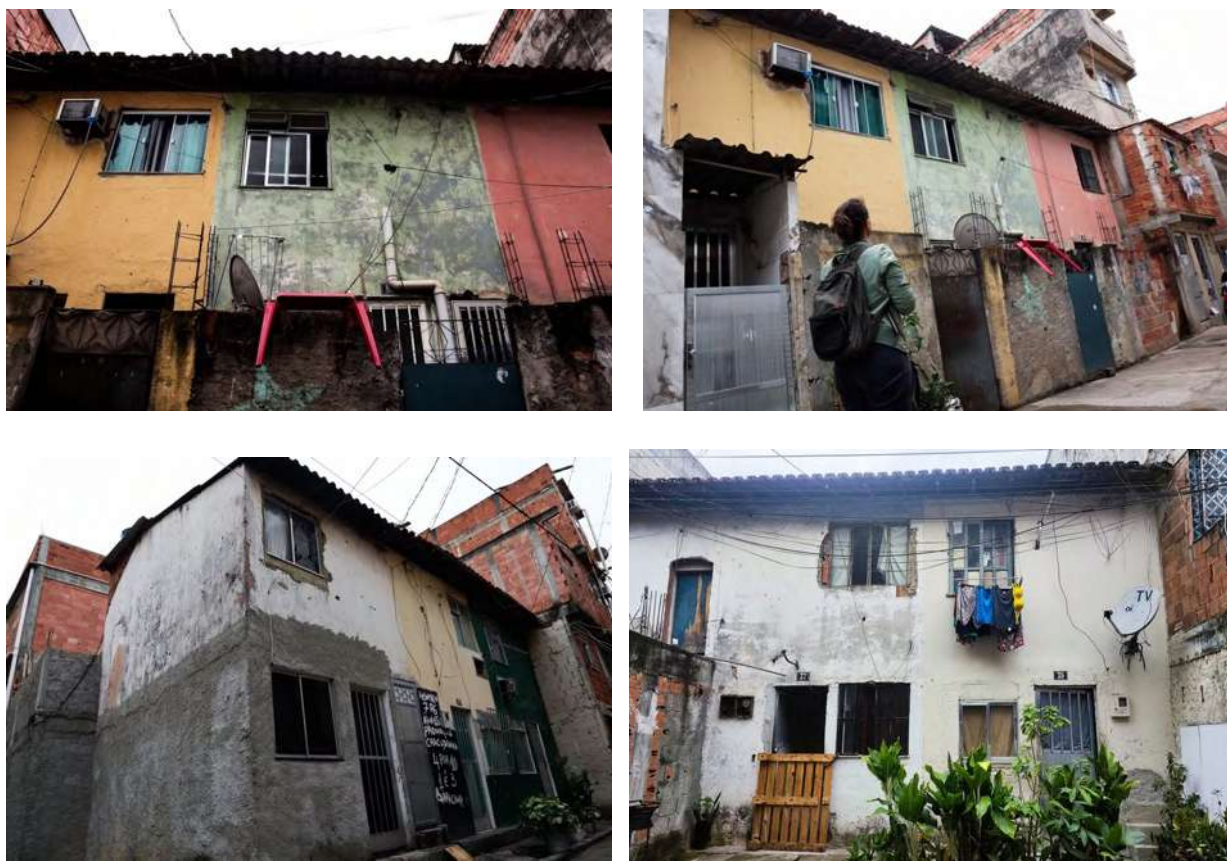
FIG. 130: FOTOS DE CASAS NO TIJOLINHO, EM NOVA HOLANDA. FONTE: ARTHUR VIANA (2023)
