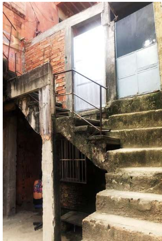
FIG. 244: ESCADA NO MEIO DO BECO PARA ACESSO AO PAVIMENTO SUPERIOR EM NOVA HOLANDA. FONTE: ARTHUR VIANA (2023)
