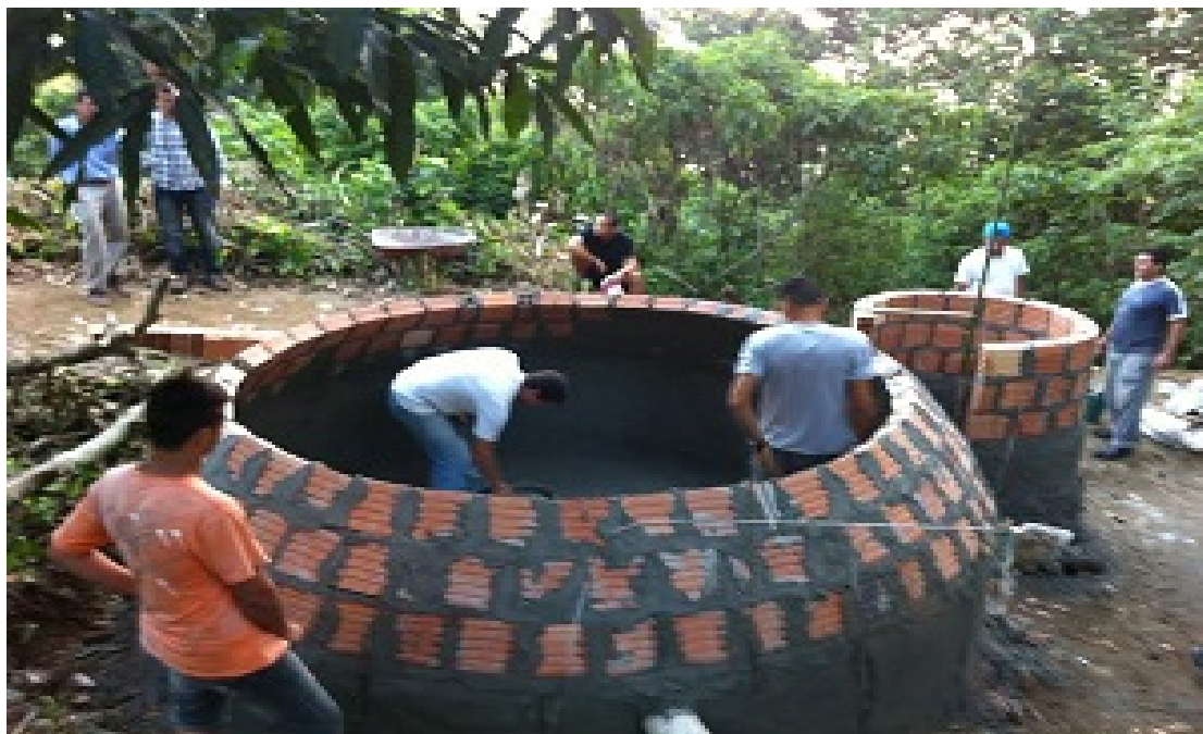
Imagens 11: Construção do biodigestor do biossistema utilizado para o tratamento de esgoto da comu- nidade
