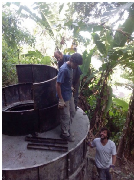
Imagens 8,9 e 10: Biodigestor que trata a matéria orgânica proveniente da cozinha: processo de montagem da estrutura metálica usada como forma para fazer a concretagem da parede de cilíndrica
